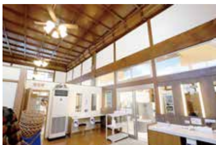
▲男湯の脱衣場。格式ある折り上げ格天井(ごうてんじょう)に昔の面影を残しています
